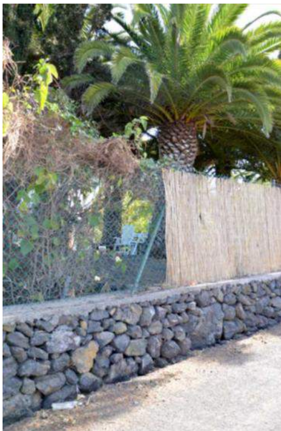
FOTOGRAFIA 26 y FOTOGRAFIA 27 En la conservación de la privacidad deben evitarse siempre elementos inflamables conductores del incendio forestal
