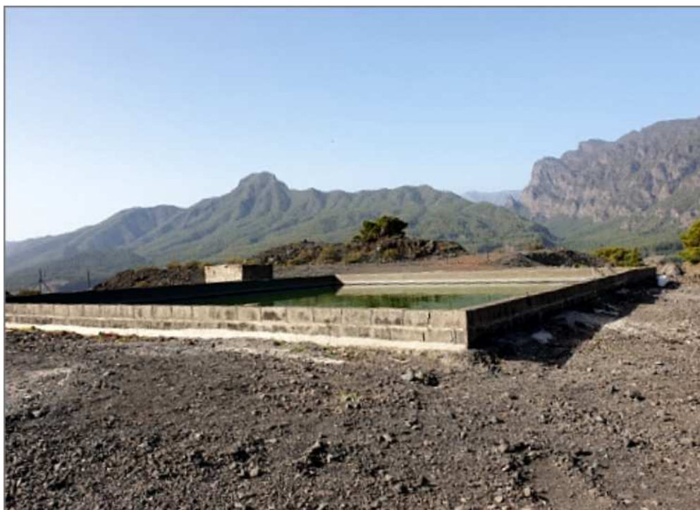
FOTOGRAFIA 11 Depósito municipal para abastecimiento de medios aéreos
